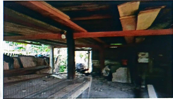
DOKUMENTASI RUMAH BAHARUDDIN SESUDAH DIBEDAH RUMAH
