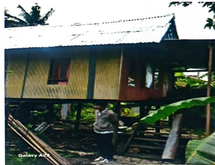
DOKUMENTASI RUMAH LUNAWATI SESUDAH DIBEDAH RUMAH
