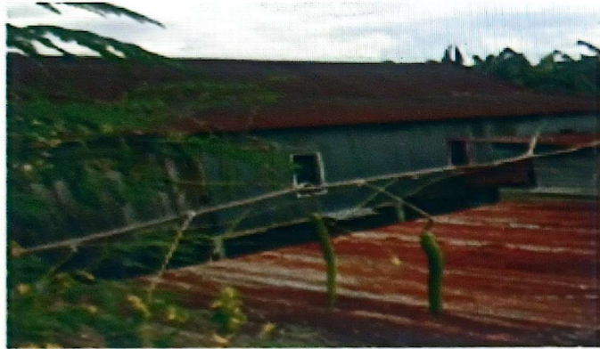
DOKUMENTASI RUMAH NURDIN SEBELUM DIBEDAH RUMAH
